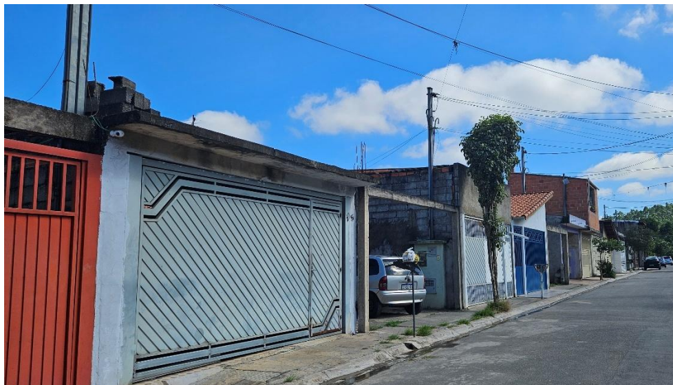
Figura 39: Residência com características construtivas distintas ao original entregue, inclusive com construção de mais pavimentos Fotografia: Felco Faleiros, mar./2025
