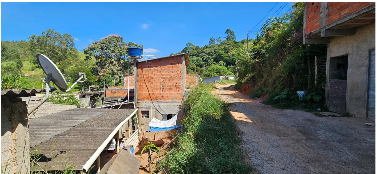
Figura 66: Moradia em área de alto risco – Rua Eugênia Soares da Silva Fotografia: Felco Faleiros, mar./2025
