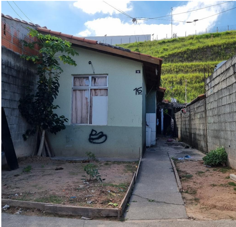
Figura 38: Residência com características construtivas próximas ao original entregue Fotografia: Felco Faleiros, mar./2025
