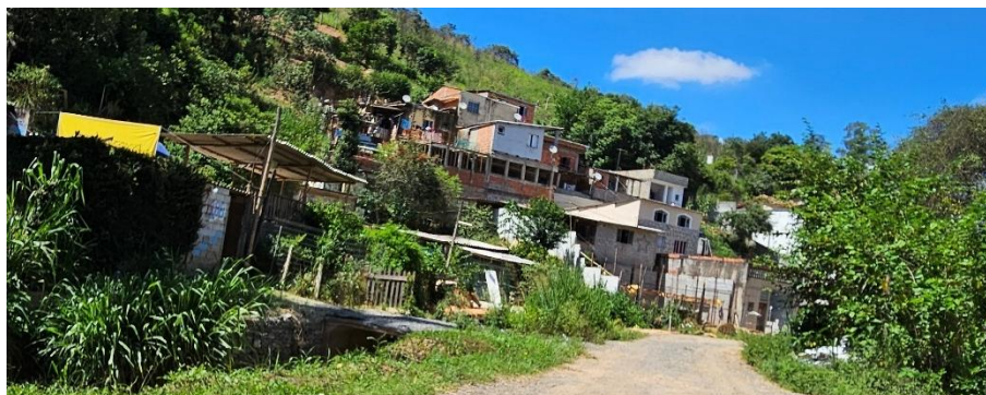
Figura 71: Moradias em área de alto risco – favelização – Rua Alvorada Fotografia: Felco Faleiros, mar./2025
