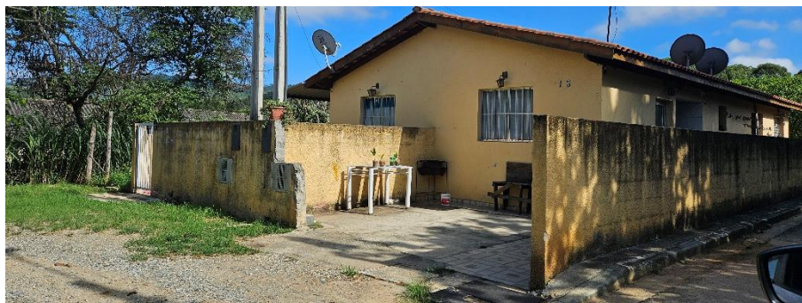
Figura 33: Unidades habitacionais construídas - Rua Isaías Pedroso de Oliveira, Centro
