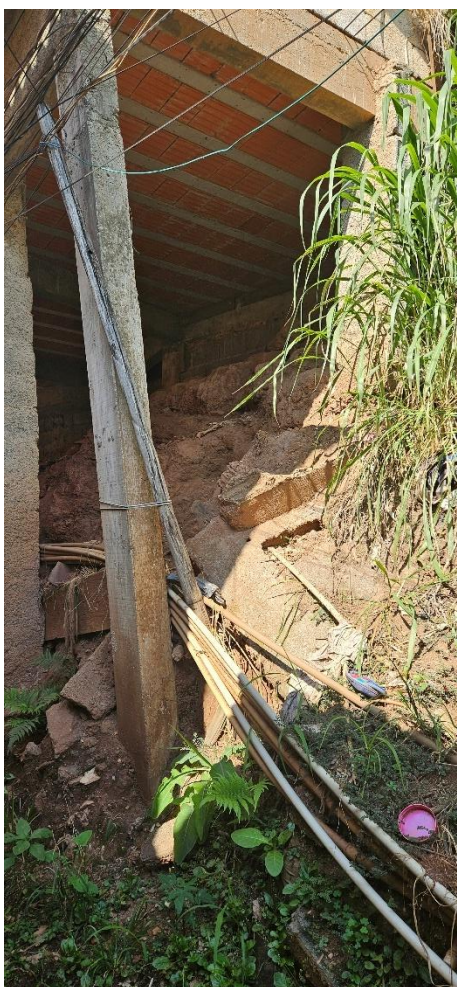
Figura 72: Risco de desmoronamento na viela da Rua Cruzeiro e necessidade de contenção do córrego por meio da construção de muro de gabião Fotografia: Felco Faleiros, mar./2025
