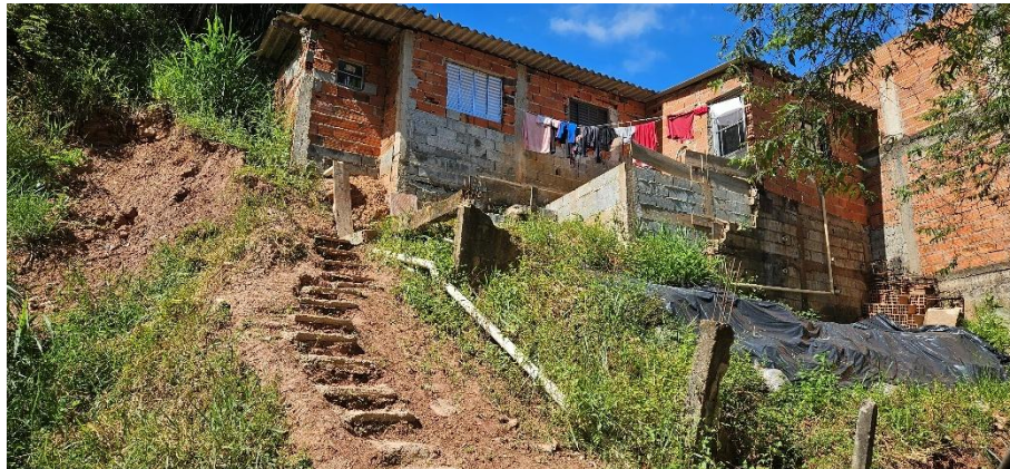
Figura 62: Moradia ocupada, apesar dos riscos (deslizamento e desmoronamento) apresentados- Sítio Bela Vista
