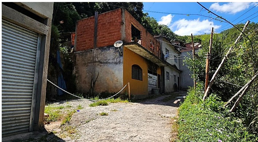
Figura 70: Moradias em área de alto risco – remoção de famílias – deslizamento de terra – área interditada – Rua Taquaral Fotografia: Felco Faleiros, mar./2025
