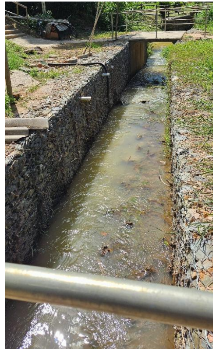
Figura 68: Moradia em área de alto risco – favelização e contenção com muro de gabião – Rua Brasilândia
